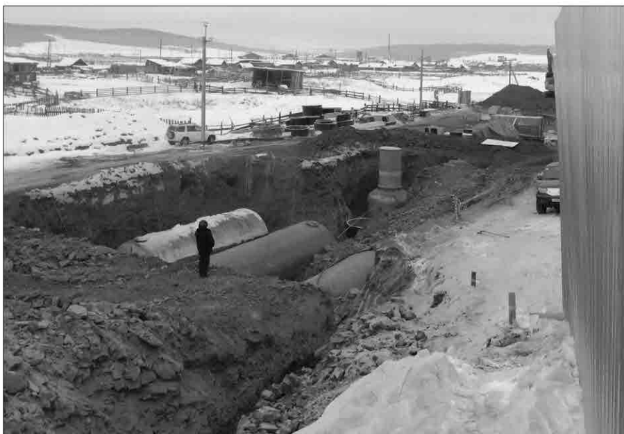
Идёт прокладка коммуникации
